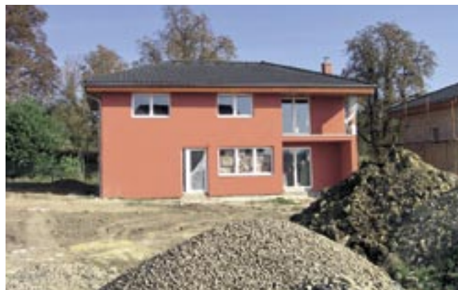
Realizace vazníkového krovu (9,4 × 15m), střešního pláště (KM Beta), klempířských konstrukcí a obkladu říms palubkami na rodinném domě v Jirnech. Celkem byly realizovány čtyři totožné domy.
