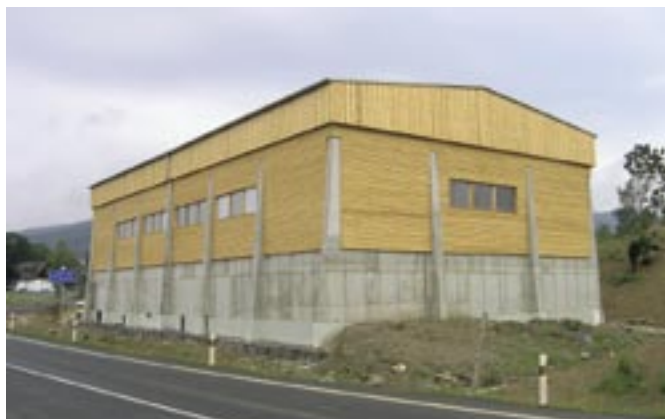
Realizace střešní vazníkové konstrukce, dřevěné konstrukce stěn a dřevěného opláštění překládanými prkny na skladu soli v Ostrově u Karlových Varů. Půdorysná dispozice má rozměry 15,3 × 30 m.
